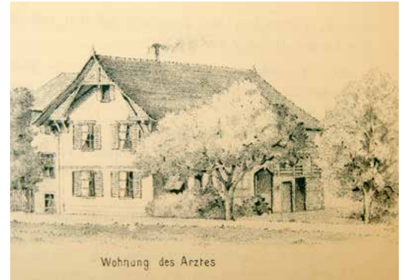
Das 1884 erbaute Doktorhaus enthielt nicht nur die Arztwohnung, sondern auch ein Untersuchungszimmer, einen Warteraum und eine Apotheke.
