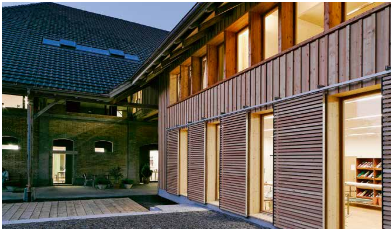
Das renovierte Bauernhaus mit Blick ins Gestaltungsatelier.
